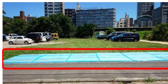
<コンパネによる養生例>
